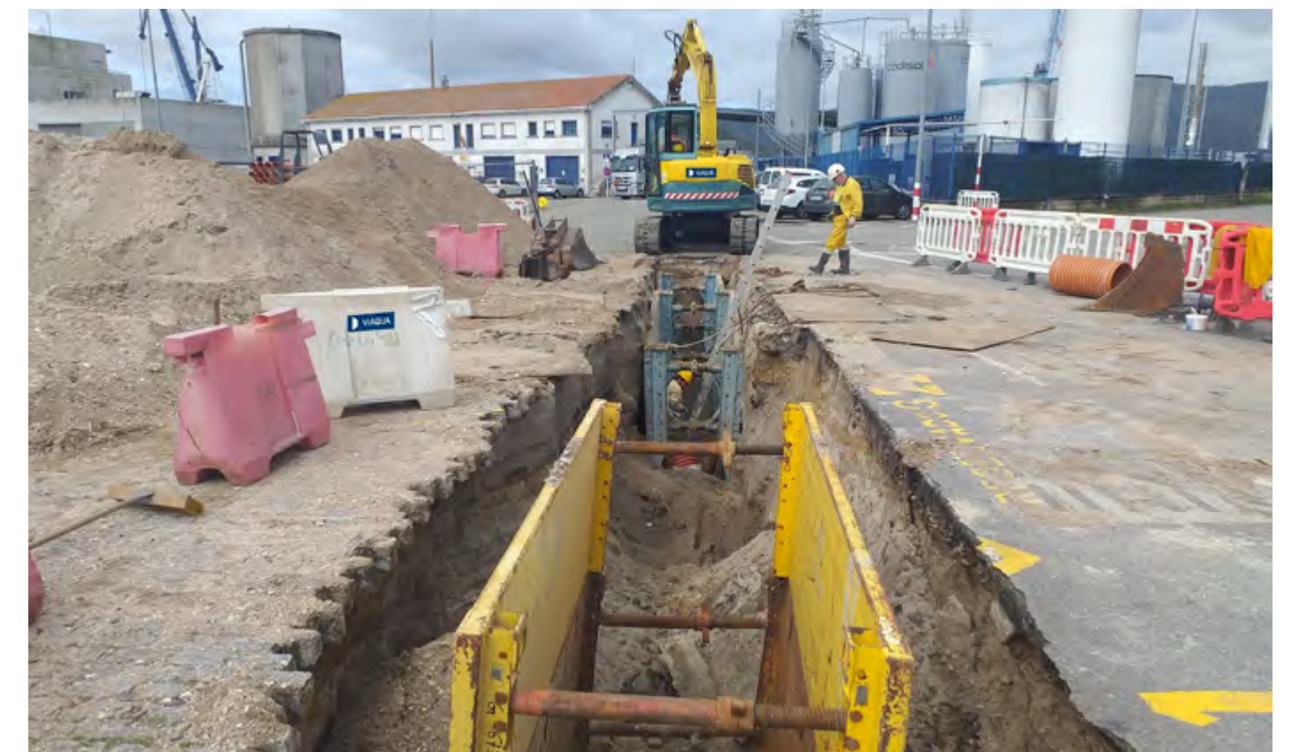
Obra realizada por Viaqua no porto de Marín
